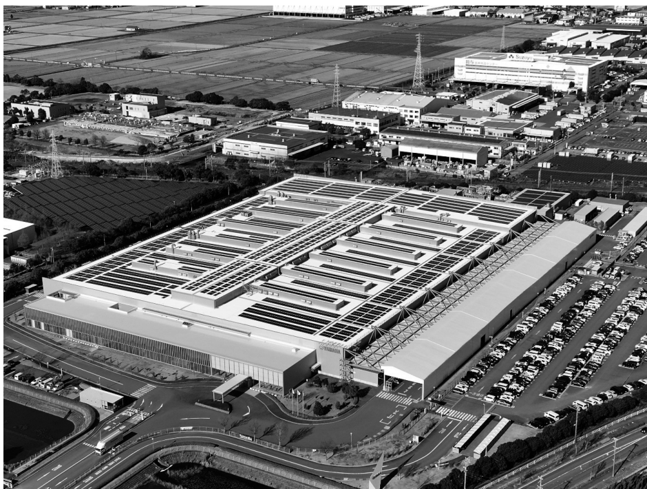
図11 ヤマハ発動機 袋井南工場（静岡県袋井市）
